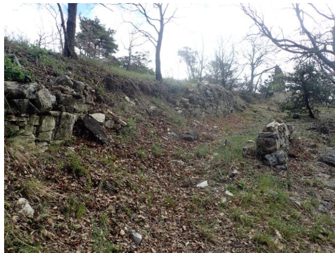
Murets en pierre sèche Source : Alpicité, 2021
